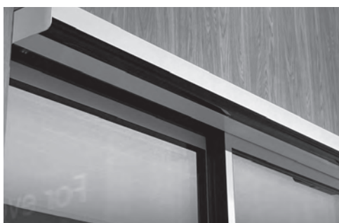
センサー内蔵 黒い窓の中に赤外線センサーが隠されています。
